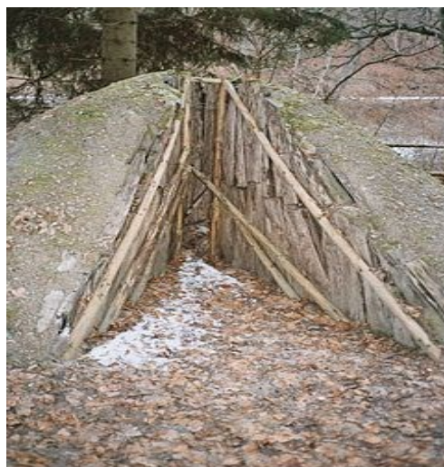
Legősibb technológia: szénégetés „boksában” 3 500 éve ismert
